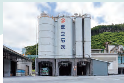
2020年に刷新されたタンカル工場
